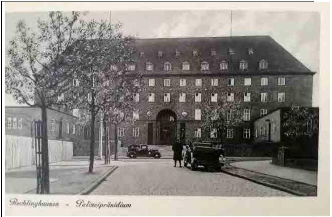
Polizeipräsidium Recklinghausen, Sitz der Gestapo Anfang 1939: Der Bauzaun links verdeckt das Gelände der am 9./10. November 1938 zerstörten Synagoge (Foto: Institut für Stadtgeschichte)
