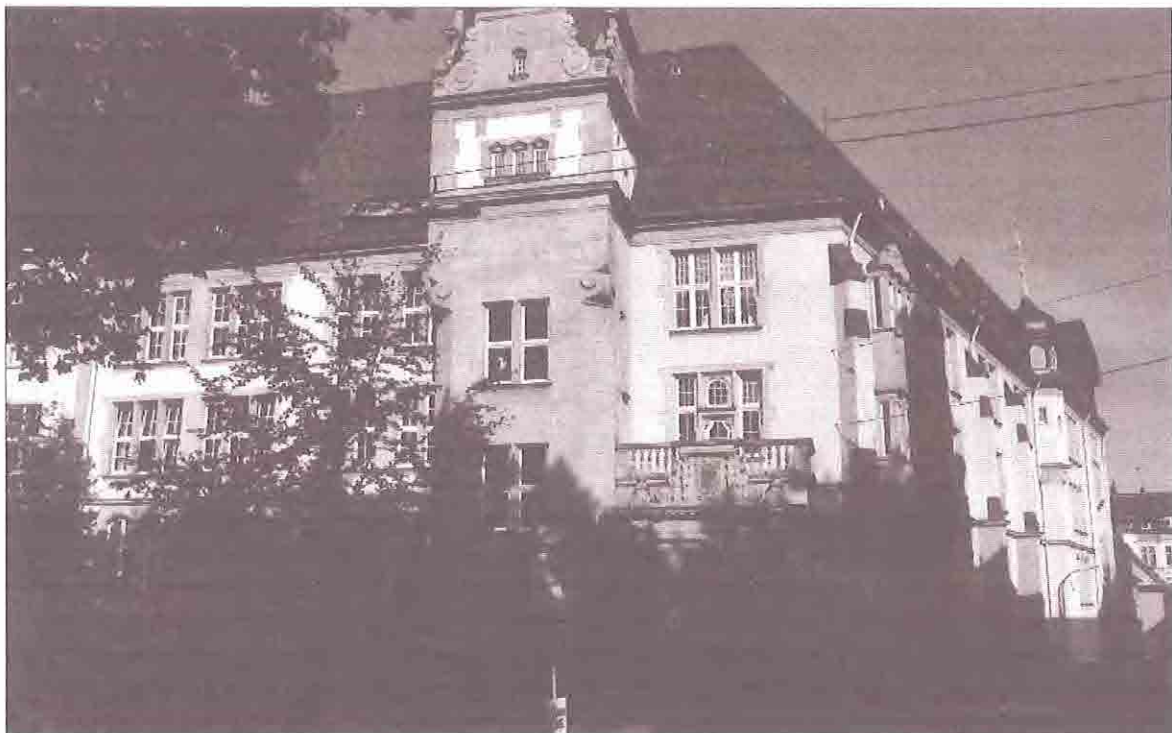
Gymnasium Petrinum, Herzogswall
